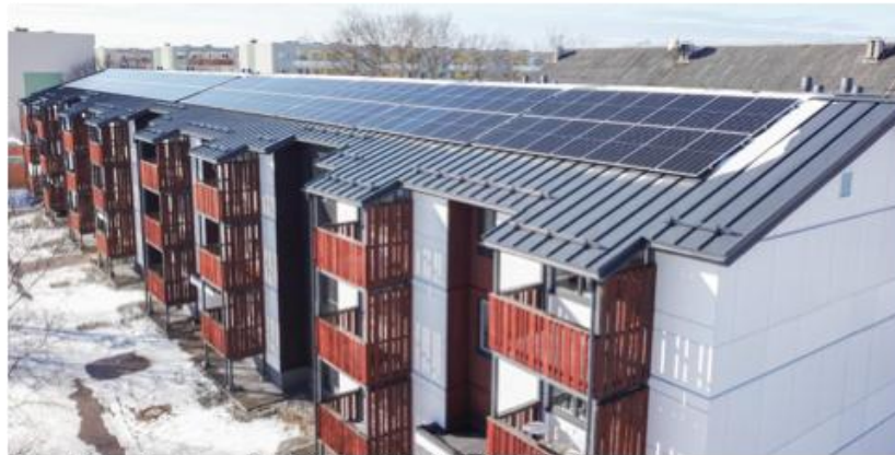
Kuuma 4 tehasele renoveerimise pilootprojekt. Foto: Timbeco/ Eero Nigumann.
