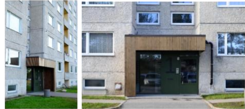
Paneelilamade sissepääsude uuendamiseks on kasutatud olemasoleva maja jaoks küll uut, kuid muidu Eestile omast ja hubast puitmaterjali, mis annab majale mõnusa arhitektuurse aktsendi, rõhutab välisuste asukohti ja loob taskukohase võimaluse eristuda sarnasest naaberhoonest. Fotod: Riina Lii Pare.
